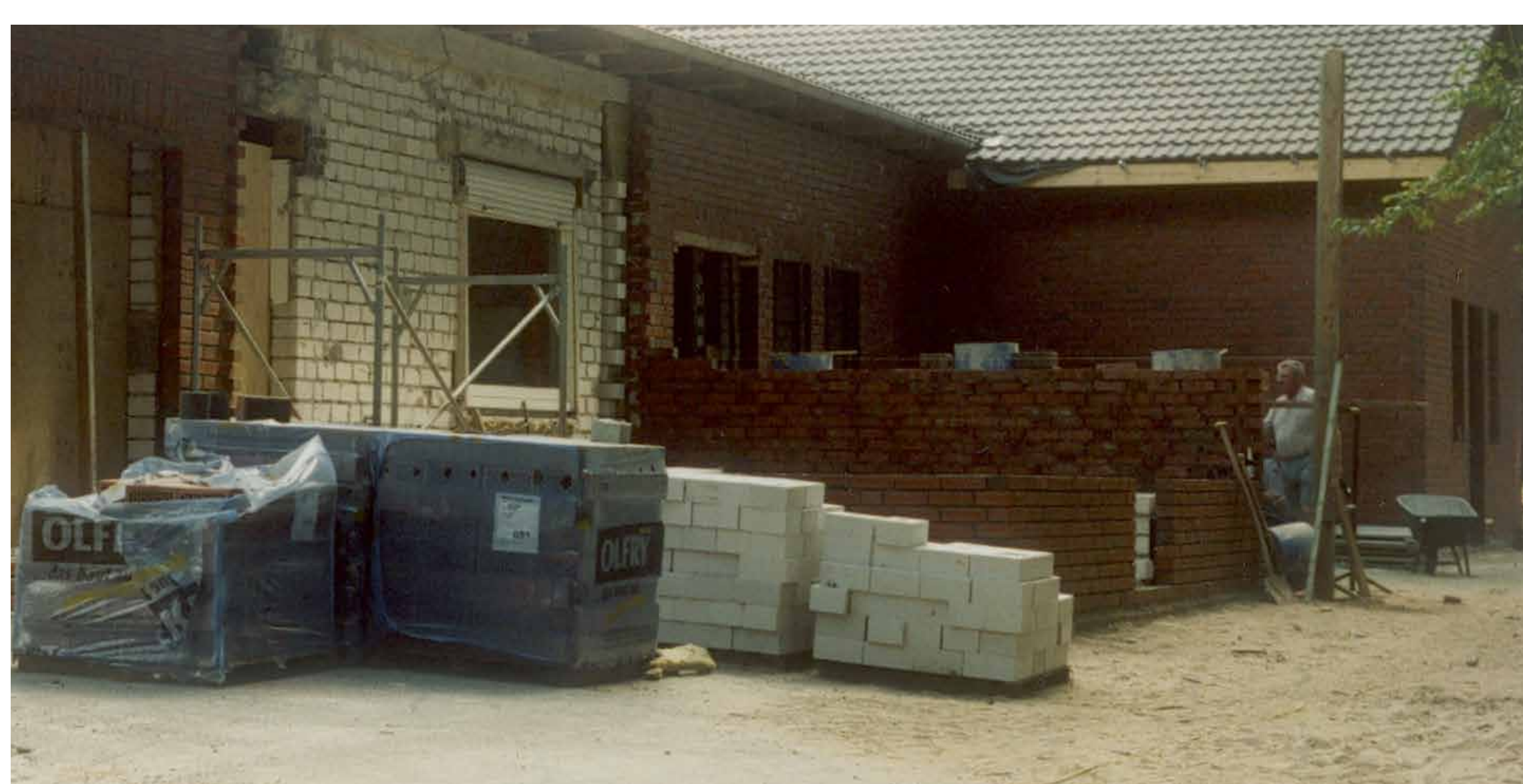
Der Bühnenvorbau entsteht.
