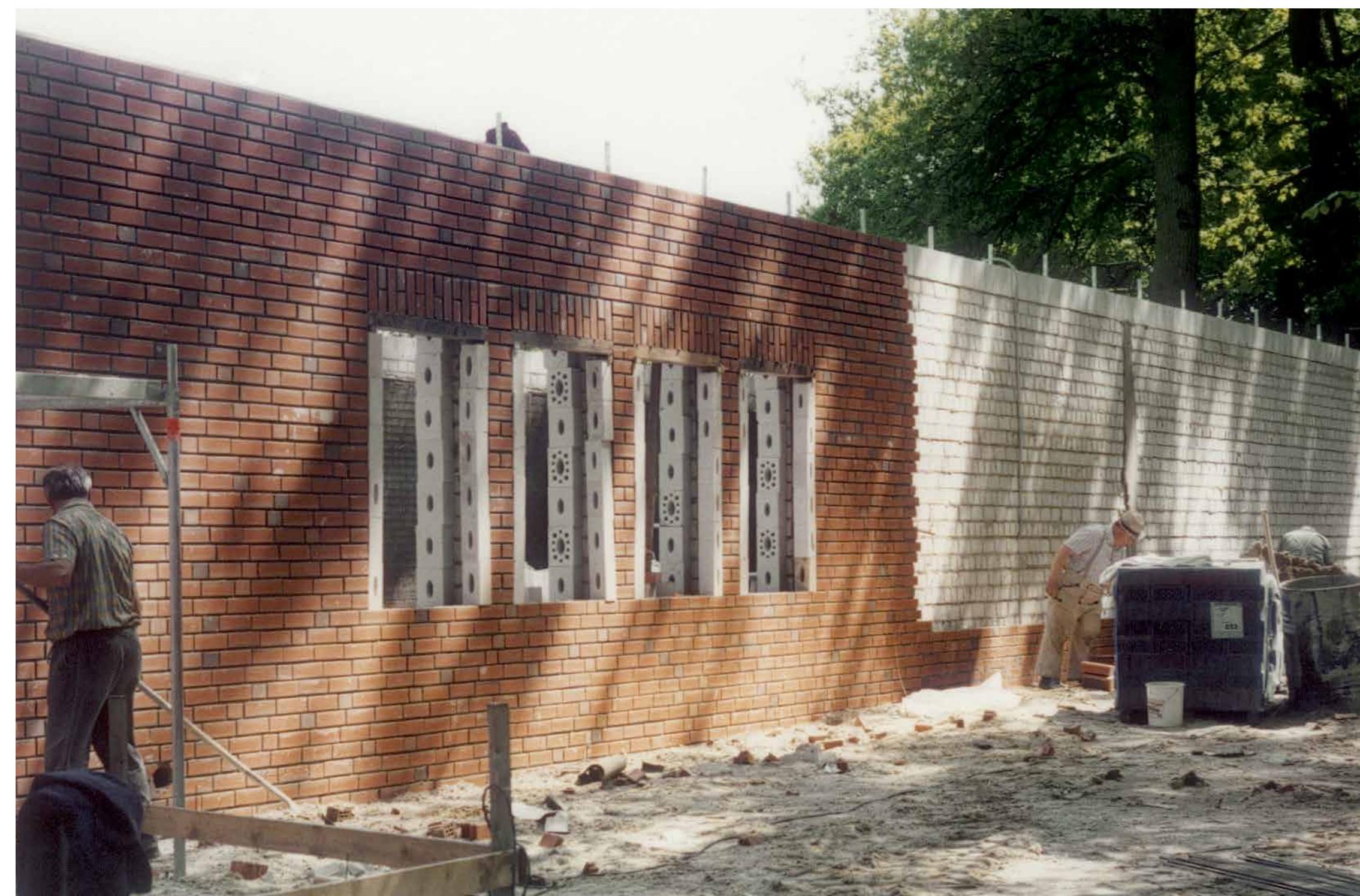
Der Anbau nimmt Formen an.
