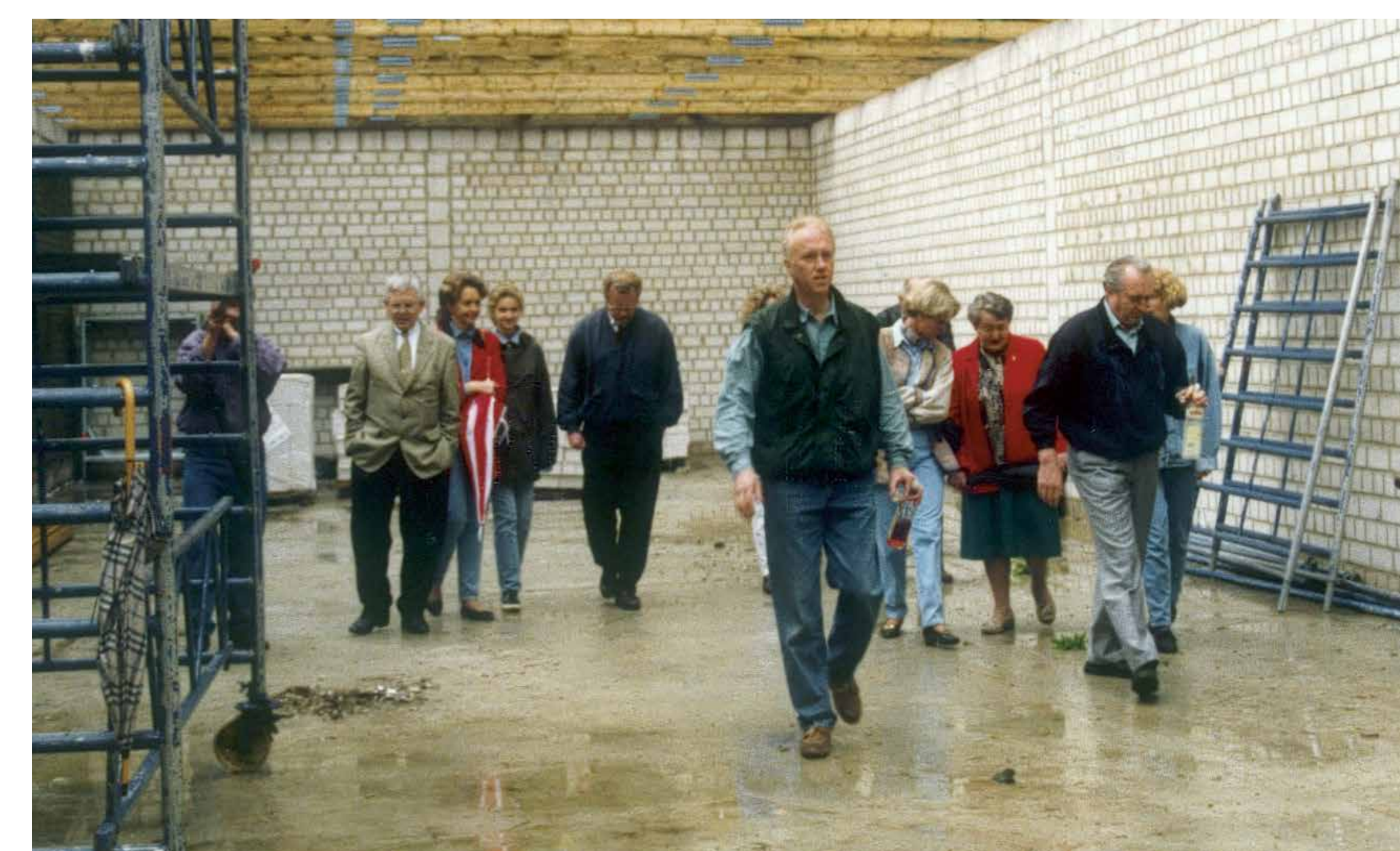
Nach dem Richtfest folgt die Abnahme des Rohbaus.
