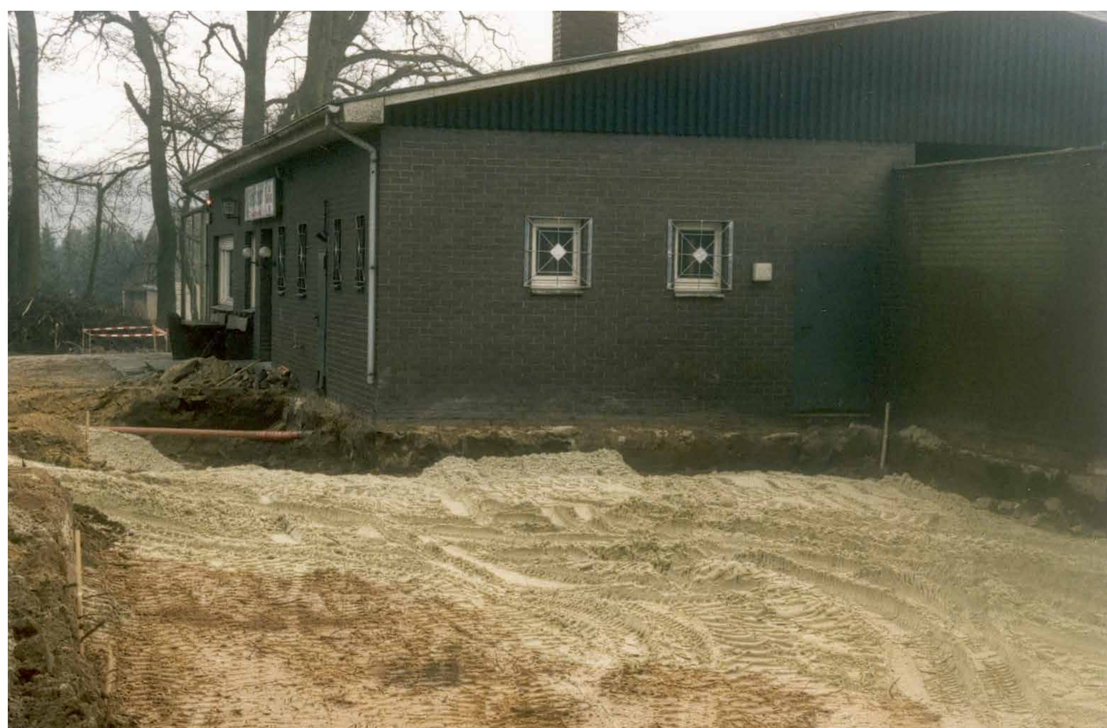
Hier soll der Luftgewehrstand gebaut werden.
